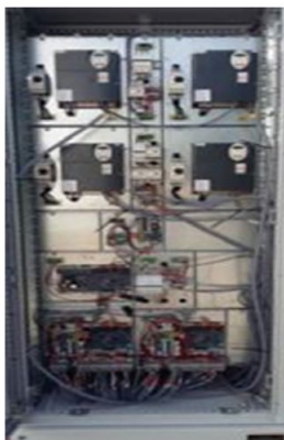
Convertisseurs de fréquence entraînements de ventilateur + entraînements de pompe + cartes électroniques
