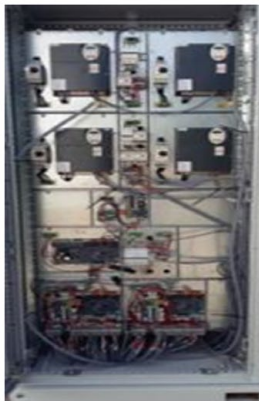
Armoire pour ventilateur, pompe et commande
