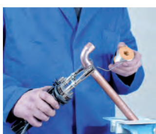
5. Appliquer la soudure
